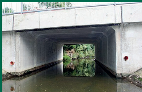
1. Nevhodné řešení. Mosty, kde voda sahá od opěry k opěře, vydry zpravidla neprocházejí.
