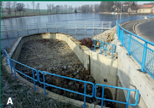
2. Nevhodné řešení. I když samotný průchod mostkem pod silnicí (obr. B) je v tomto případě pro vydru bezproblémový, bezpečnostní přepad s vysokou přelivnou hranou znamená pro vydru nepřekonatelnou bariéru. Zde navíc vytvářejí bariéru kromě vysokého přelivu také kovové česle oddělující bezpečnostní přepad od zbytku rybníka (obr. A).
