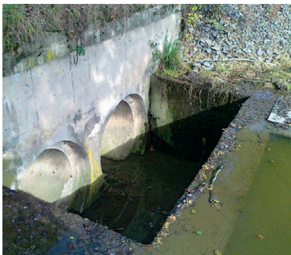
33. Detail neprůchozího přelivu rybníka Rozňák.
