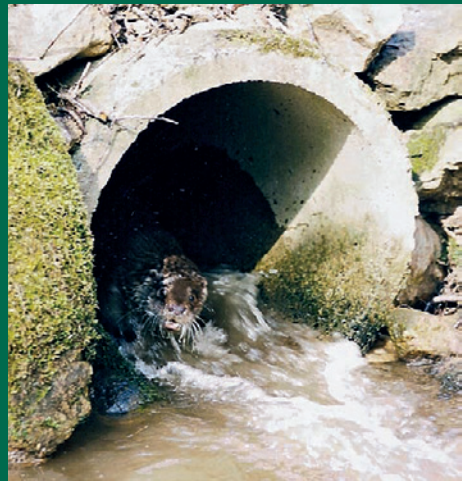
2. Vhodné řešení. Propustky, kde množství protékající vody umožňuje vydrě jít po dně, jsou pro ni většinou průchozí.
