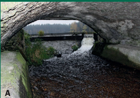
3. Vhodné řešení. Bezpečnostní přepad s výškovým stupněm do 20 cm je pro vydru průchozí
