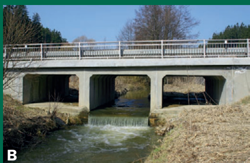
1. Nevhodné řešení. Mosty, kde voda sahá od opěry k opěře, vydry zpravidla neprocházejí.
