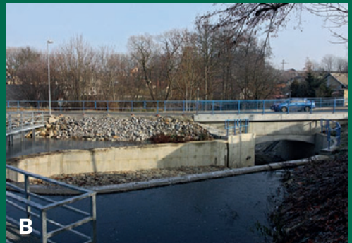
2. Nevhodné řešení. I když samotný průchod mostkem pod silnicí (obr. B) je v tomto případě pro vydru bezproblémový, bezpečnostní přepad s vysokou přelivnou hranou znamená pro vydru nepřekonatelnou bariéru. Zde navíc vytvářejí bariéru kromě vysokého přelivu také kovové česle oddělující bezpečnostní přepad od zbytku rybníka (obr. A).
