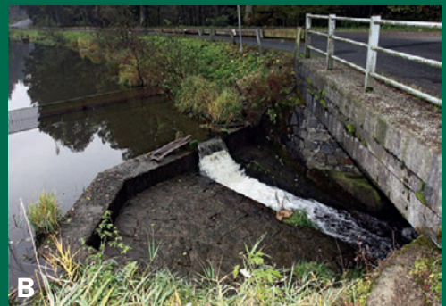
3. Vhodné řešení. Bezpečnostní přepad s výškovým stupněm do 20 cm je pro vydru průchozí
