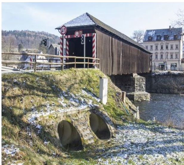
Abb. 29: Trockentunnel als Alternative zur Berme an der Zschopau und der Biela
