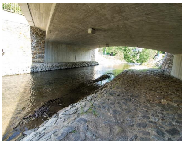
Abb. 31: Beispiele für fest verbaute Bermen aus gemauerten Steinen und Beton an Bobritzsch und Schwarzer Pockau
