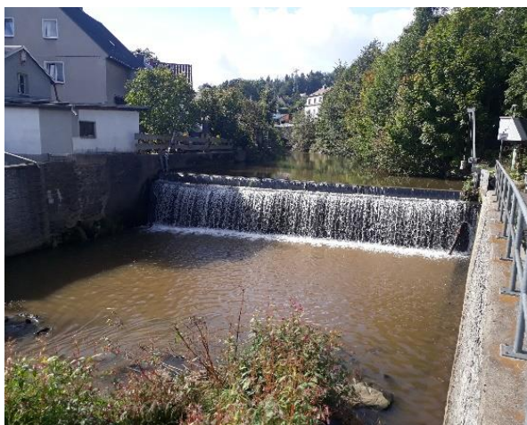
Abb. 34: Wehr ohne Auf- oder Abstiegshilfe und mit unüberwindbaren Ufermauern (links) und Wehranlage mit eingebauter Fischtreppe (rechts) an der Flöha
