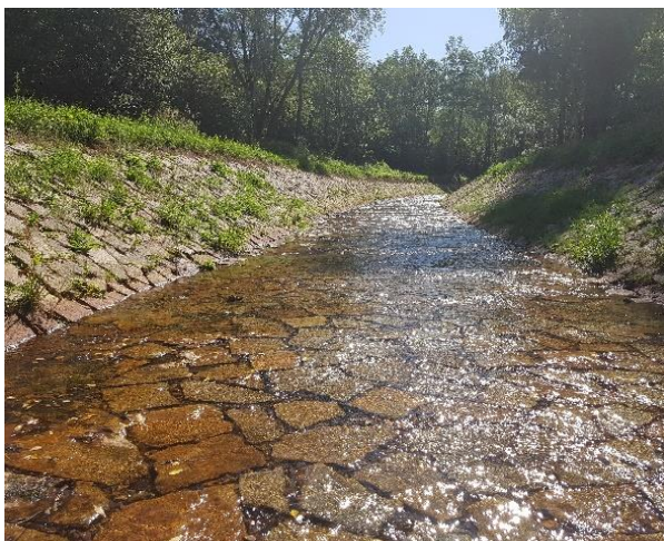
Abb. 33: Bachabschnitt mit strukturarmer, befestigter Sohle und künstlicher Uferbefestigung an der Bahra (links). Im Gegensatz dazu Inseln, Totholz, und unterschiedlichen Solsubstraten an der Bobritzsch (rechts)
