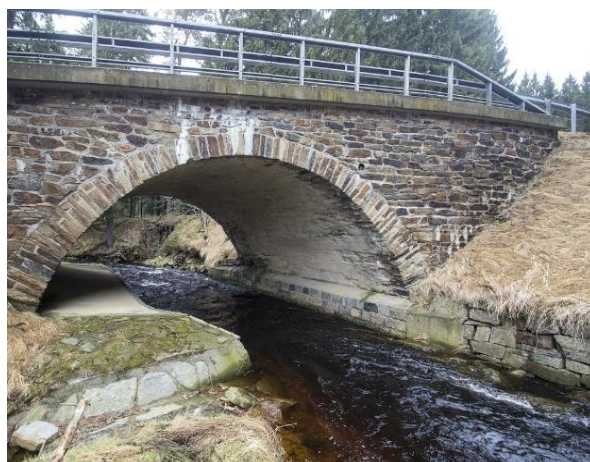
Abb. 31: Beispiele für fest verbaute Bermen aus gemauerten Steinen und Beton an Bobritzsch und Schwarzer Pockau
