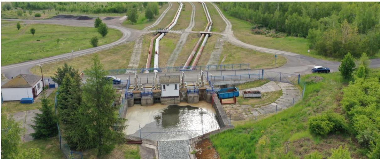
Abb. 18: Verrohrung der Bílina am Ervěnický koridor
