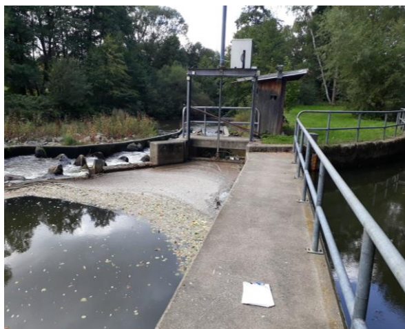
Abb. 34: Wehr ohne Auf- oder Abstiegshilfe und mit unüberwindbaren Ufermauern (links) und Wehranlage mit eingebauter Fischtreppe (rechts) an der Flöha
