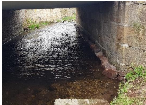
Abb. 30: Zustand vor und nach der Ablagerung von großen Steinen zur Schaffung eines trockenen Uferstreifens am Cunnersdorfer Bach
