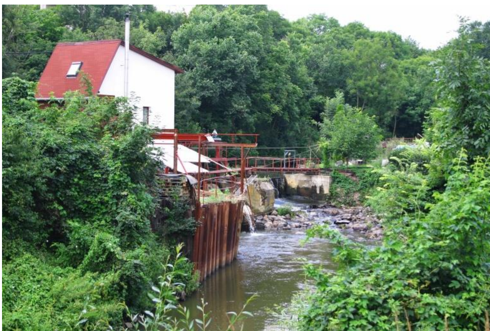
Obr 12: Mírně rizikové místo: Jez malé vodní elektrárny u Chanova
