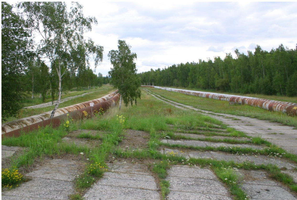
Obr 2: Řeka Bílina v úseku Ervěnického koridoru je svedena do potrubí.
