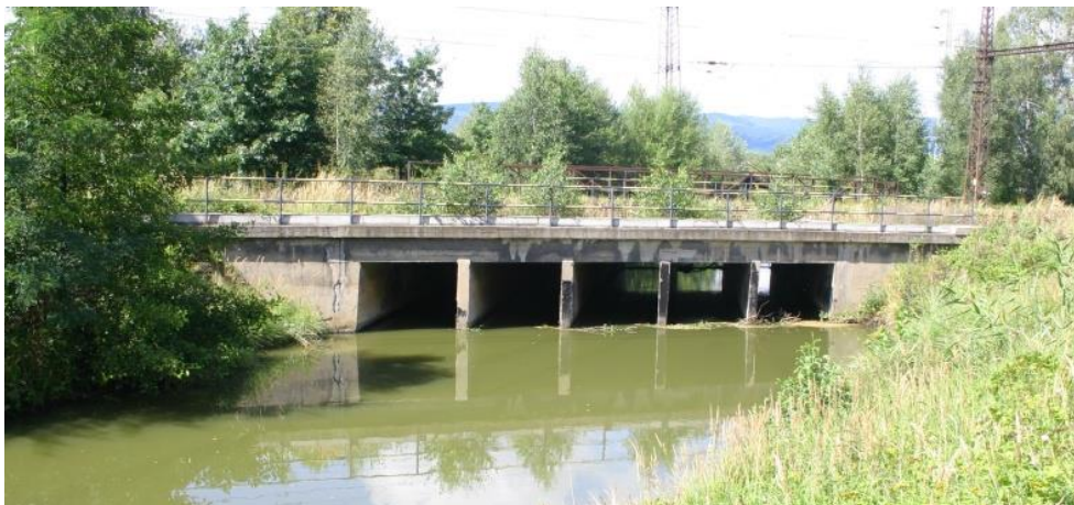
Obr 11: Mírně rizikové místo: železniční most u Dolního Jiřetína.
