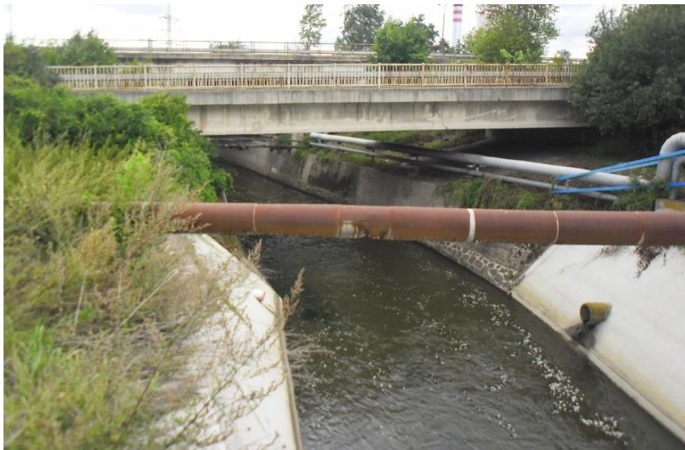
Obr 15: Regulovaný úsek u Chudeřic: úsek mohou vydry projít vodou nebo po břehu po pravé straně, kde ale musí překonat dvě silnice. Vedlejší paralelní silnici musí vydry při putování po břehu překonat vrchem. Riziko úseku je zejména v nepřehlednosti.
