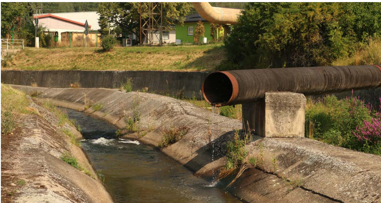
Abb. 16. Der aus dem Erzgebirge abfließende Saubach (Hutná) wird auf diese Art und Weise in das Wasserzuführungssystem Podkrušnohorský přivaděč eingeleitet. Der Fischotter findet hier zwar einen Weg zum Bach, aber für die Fische und die Wirbellosen stellt diese Stelle eine Unterbrechung des Flussnetzes dar (Aufnahme Kateřina Poledníková); Fig. 16. The Hutná stream flowing from the Ore Mountains connects to the Podkrušnohorský feeder in this way. Otters will find their way to the stream, but for fish and invertebrates it is a complete interruption of the river network (photo by Kateřina Poledníková)
