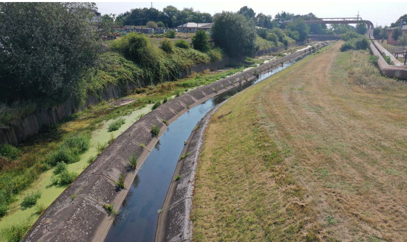
Abb. 15. Das Wasserzuführungssystem Podkrušnohorský přivaděč ist ein künstliches System von Kanälen, mit denen die Eger und die Biela verbunden werden. Durch dieses System wird das Wasser der kleinen Fließgewässer des Erzgebirges aufgenommen. Die Folge ist ein stark verändertes Flussnetz im Brüxer Becken (Aufnahme Jindřich Poledník); Fig. 15. The Podkrušnohorský feeder is an artificial structure, a system of water canals uniting the Ohře and Bílina rivers and collecting water from the small streams of the Ore hory mountains. Due to the feeder, the original river network in the Most basin is very altered (photo by Jindřich Poledník)
