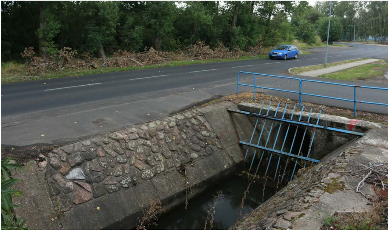
Abb. 17. Der Sviní potok bei Kosten (Košťany) wurde auf 380 m in einen unterirdischen Kanal umgeleitet. Für den Fischotter ist dies ein Hindernis. Bei dem Versuch es zu überwinden, gelangt er auf die Straße und in den Innenbereich der Gemeinde. Somit ist es für den Fischotter eine sehr gefährliche Stelle (Aufnahme Kateřina Poledníková); Fig. 17. The Sviní stream near the village of Košťany is drained into an underground canal in the length of 380 meters. For otters, it is a barrier that, if they try to overcome, they get on the road and into the village. So it is a very dangerous place (photo by Kateřina Poledníková)
