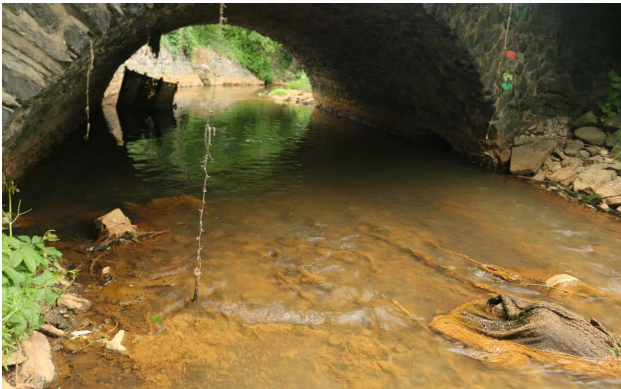
Obr. 21. Potok Bystřice pod Teplicemi: častým problémem vodních toků v Mostecké pánvi je znečištění – komunální i průmyslové (foto Kateřina Poledníková); Fig. 21. Bystřice stream near Teplice: a frequent problem of watercourses in the Most basin is pollution – municipal and industrial (photo by Kateřina Poledníková)
