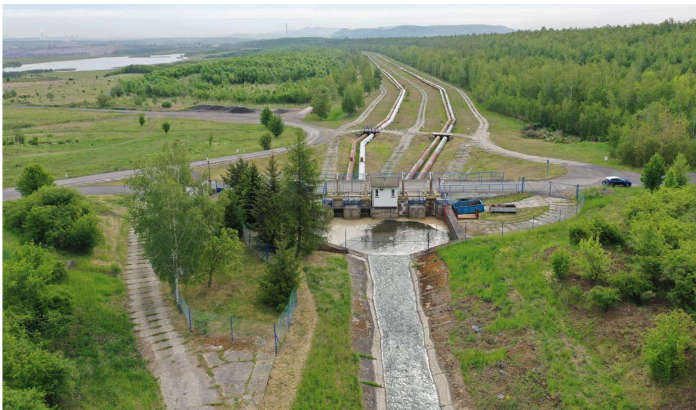
Obr. 18. Bílina je na Ervěnickém koridoru svedena v délce 3 km do čtyř potrubí. Naprostá bariéra pro veškerý život vázaný na řeku, včetně vyder či ryb (foto Jindřich Poledník); Fig. 18. Bílina river is reduced to four pipelines in the length of 3 km on the Ervěnice corridor. An absolute barrier to all life tied to the river, including otters or fish (photo by Jindřich Poledník)
