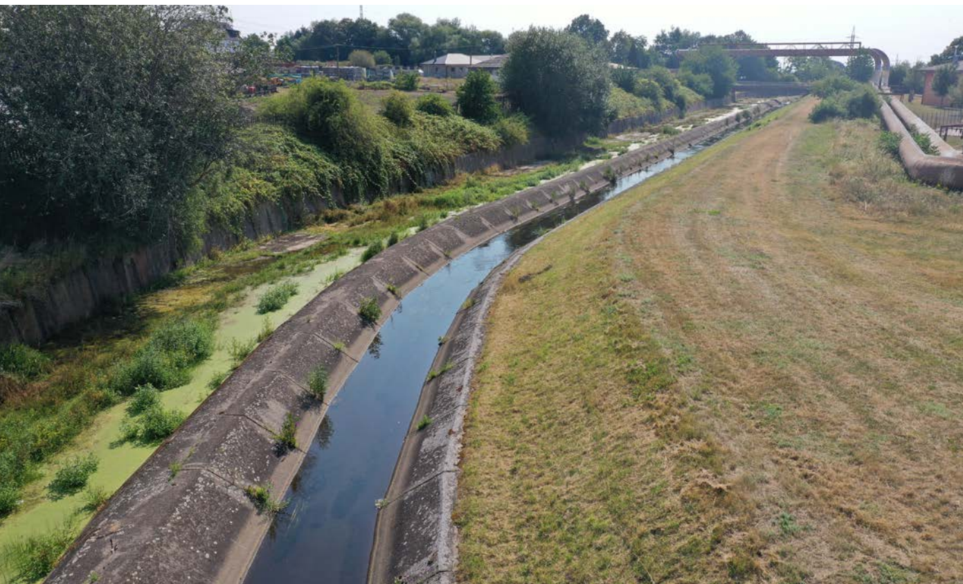
Obr. 15. Podkrušnohorský přivaděč je umělá stavba, soustava vodních kanálů spojující řeku Ohři a Bílinu a sbírající vodu z drobných toků Krušných hor. Vlivem přivaděče je původní říční síť v Mostecké pánvi velmi pozměněná (foto Jindřich Poledník); Fig. 15. The Podkrušnohorský feeder is an artificial structure, a system of water canals uniting the Ohře and Bílina rivers and collecting water from the small streams of the Ore hory mountains. Due to the feeder, the original river network in the Most basin is very altered (photo by Jindřich Poledník)
