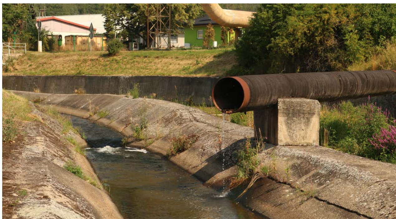
Obr. 16. Potok Hutná stékající z Krušných hor se takovýmto způsobem napojuje na Podkrušnohorský přivaděč. Vydry si cestu na potok najdou, ale pro ryby a bezobratlé je to naprosté přerušení říční sítě (foto Kateřina Poledníková); Fig. 16. The Hutná stream flowing from the Ore Mountains connects to the Podkrušnohorský feeder in this way. Otters will find their way to the stream, but for fish and invertebrates it is a complete interruption of the river network (photo by Kateřina Poledníková)
