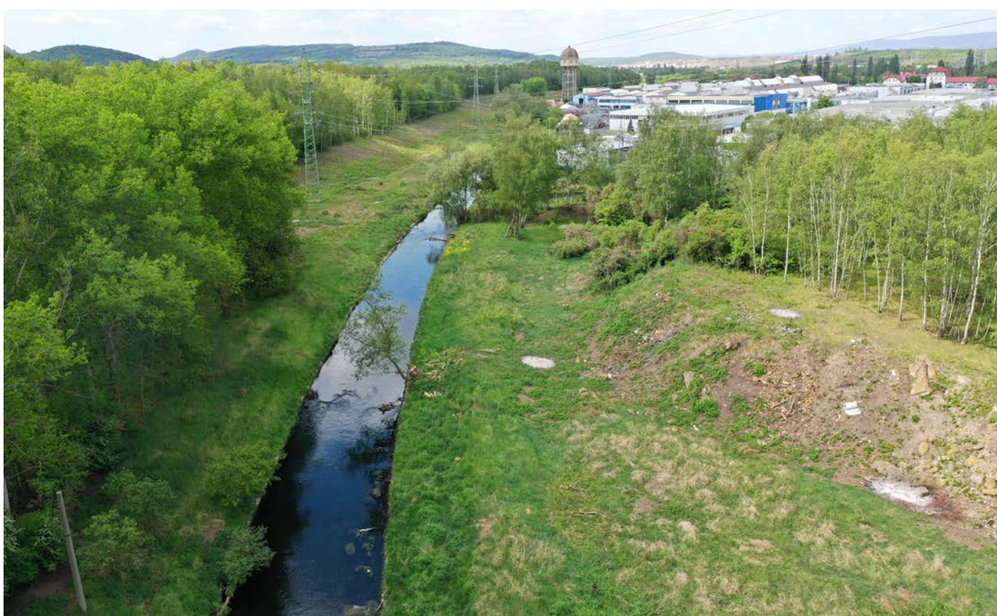
Obr. 14. Řeka Bílina již v dolním úseku – typický pohled na narovnané regulované řeky, které tečou Mosteckou pánví (foto Jindřich Poledník); Fig. 14. The Bílina river already in the lower section – a typical view of straightened regulated streams flowing through the Most basin (photo by Jindřich Poledník)
