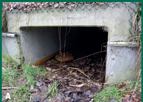
4. Vhodné řešení. Propustky s přirozeným dnem (obr. A) využívají vydry ochotněji než v případě technického dna (obr. B). Přirozené dno také umožňuje snadnější monitoring funkčnosti (viditelné stopy, v tomto případě navíc vhodně umístěný kámen vybízí vydra ke značkování).
