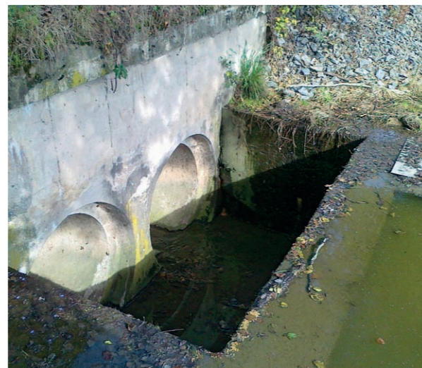
33. Detail neprůchozího přelivu rybníka Rozňák.
