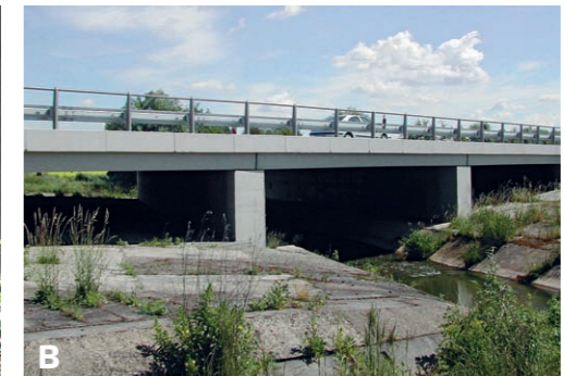
7. Průchodnost mostů pro živočichy je kromě rozměrů dána především způsobem úpravy podmostí. Vydra je sice obvykle k technickým úpravám značně tolerantní, přesto představují tyto mosty příklady nevhodného „tvrdě technického“ řešení, kdy požadavky na průchodnost pro živočichy nejsou brány v úvahu.
