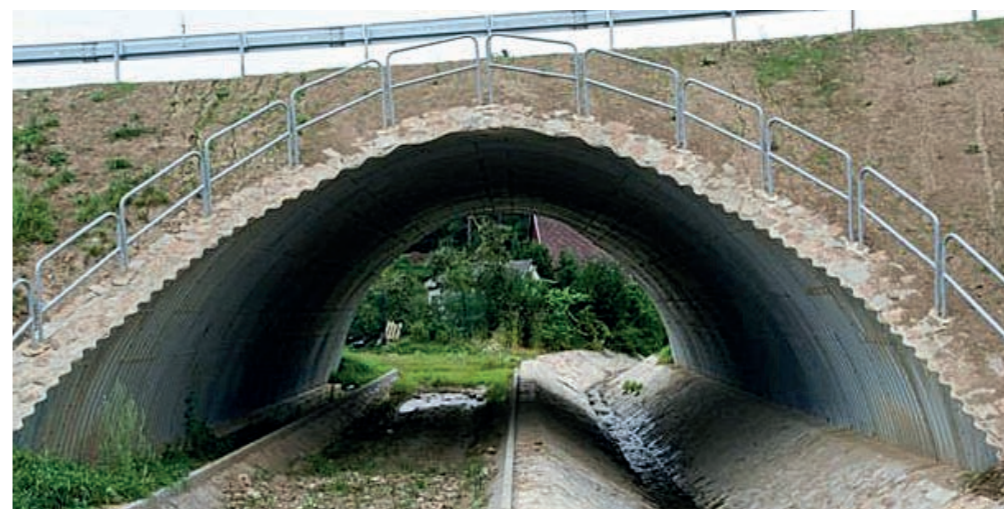
9. Konstrukce typu „Tubosider“.
