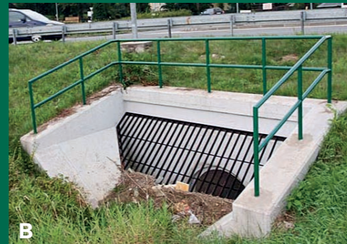
5. Nevhodné řešení. Průchodnost jinak vhodných propustků může být omezena nevhodnými technickými úpravami na vtoku: sedimentační jímka (obr. A) a česle k zachycování splavenin (obr. B).
