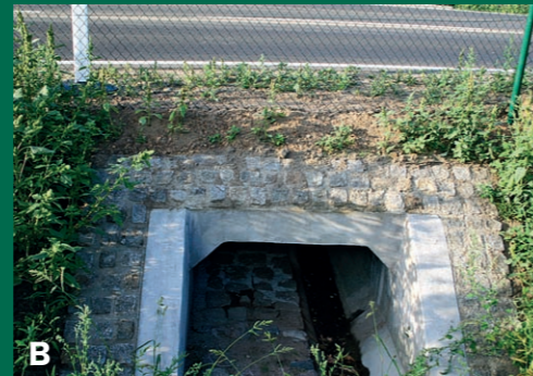
4. Vhodné řešení. Propustky s přirozeným dnem (obr. A) využívají vydry ochotněji než v případě technického dna (obr. B). Přirozené dno také umožňuje snadnější monitoring funkčnosti (viditelné stopy, v tomto případě navíc vhodně umístěný kámen vybízí vydra ke značkování).
