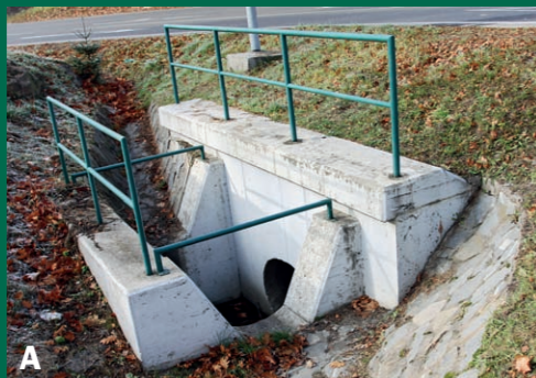
5. Nevhodné řešení. Průchodnost jinak vhodných propustků může být omezena nevhodnými technickými úpravami na vtoku: sedimentační jímka (obr. A) a česle k zachycování splavenin (obr. B).
