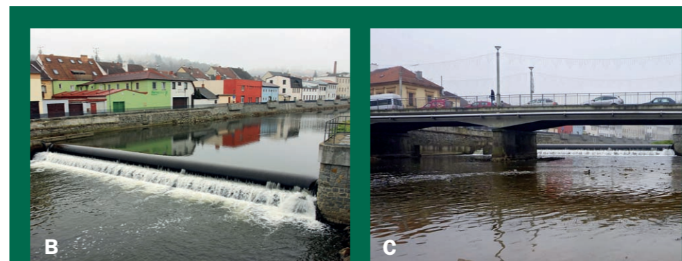
1. Dlouhé úseky toku se svislými nábřežními zdmi představují pro většinu semiakvatických živočichů migrační bariéry (obr. A – Čerkovický potok v Soběslavi). Pokud je na takto upraveném toku vytvořena příčná bariéra (např. vysoký jez – obr. B a C – jez na řece Jihlavě v Třebíči), jde o zásadní problém pro všechny živočichy včetně vydry. Při pokusu o obejití takové bariéry končí zvířata často v rušných ulicích města.
