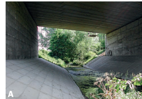
7. Průchodnost mostů pro živočichy je kromě rozměrů dána především způsobem úpravy podmostí. Vydra je sice obvykle k technickým úpravám značně tolerantní, přesto představují tyto mosty příklady nevhodného „tvrdě technického“ řešení, kdy požadavky na průchodnost pro živočichy nejsou brány v úvahu.
