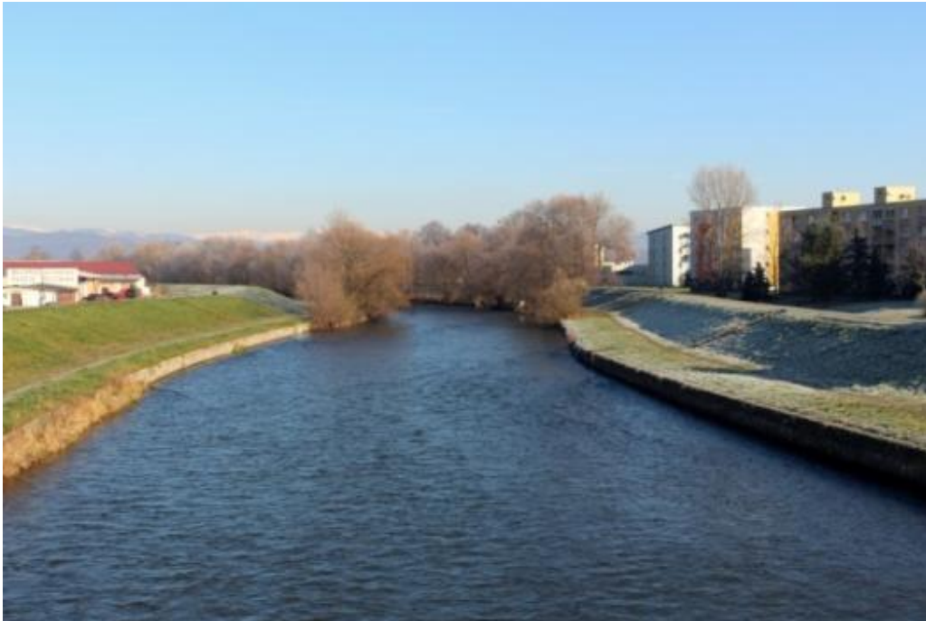
Obr. 10: Profil upraveného koryta v meste Sliač (foto P. Urban).
