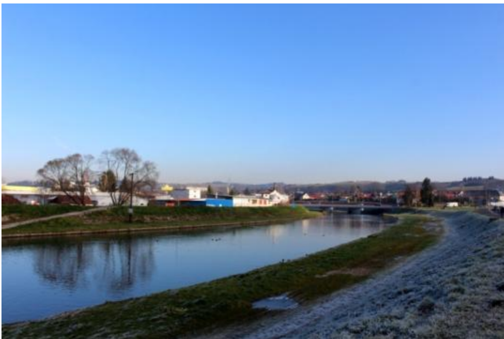
Obr. 11: Upravené koryto rieky Hron v meste Zvolen (foto P. Urban).
