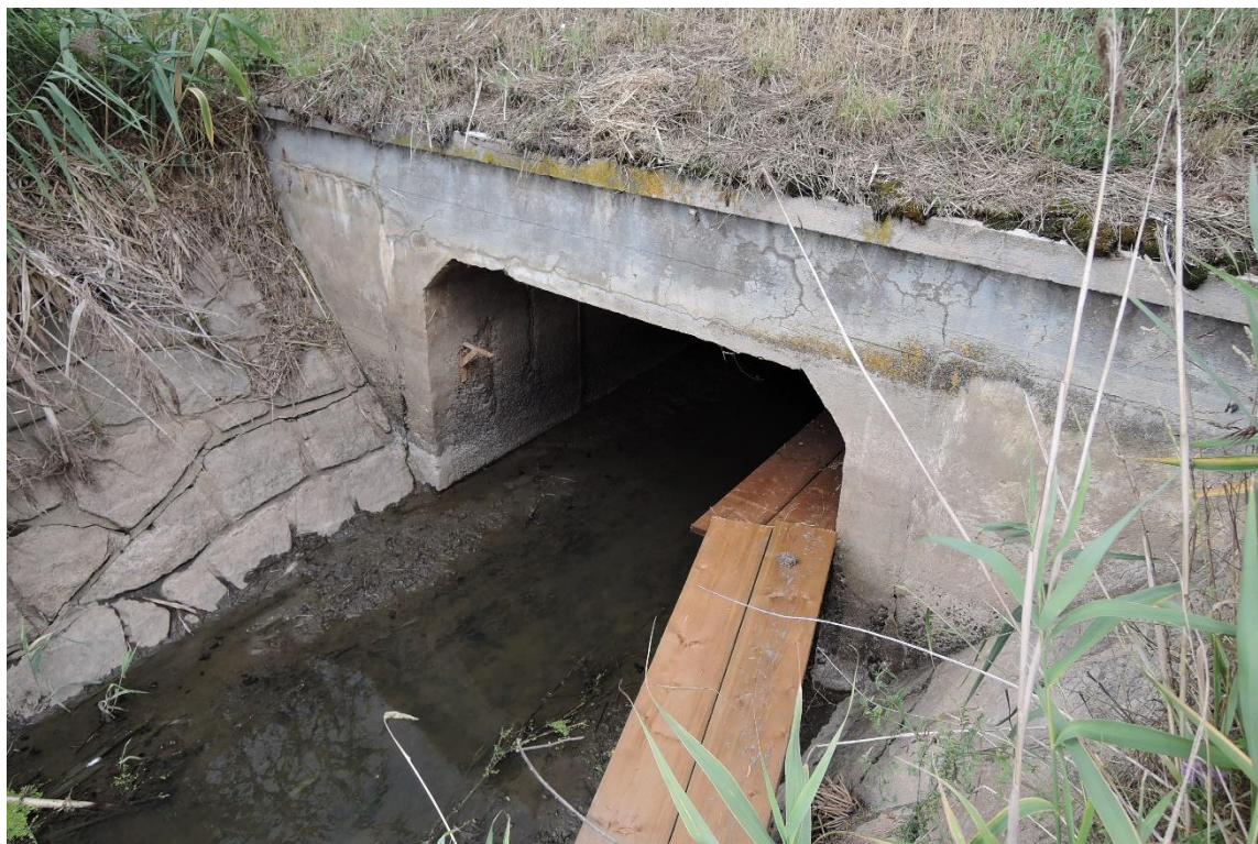
Obr. 7 Lávka instalována na Miletínském potoce, silnice č. 24, Jihočeský kraj (ID Lomnice nad Lužnicí 2)
