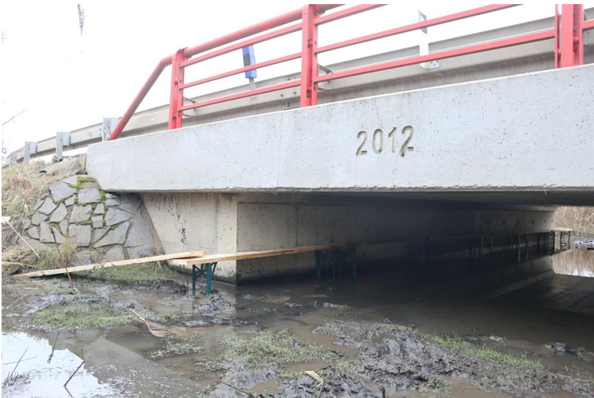
Obr. 10 Lávka instalována na výtoku z Mysliveckého rybníka, silnice č. 27, Ústecký kraj (ID Luční potok 1) Fig. 10 Board installed on channel of Myslivecký pond, road no. 27, Ústí region (ID Luční potok 1)
