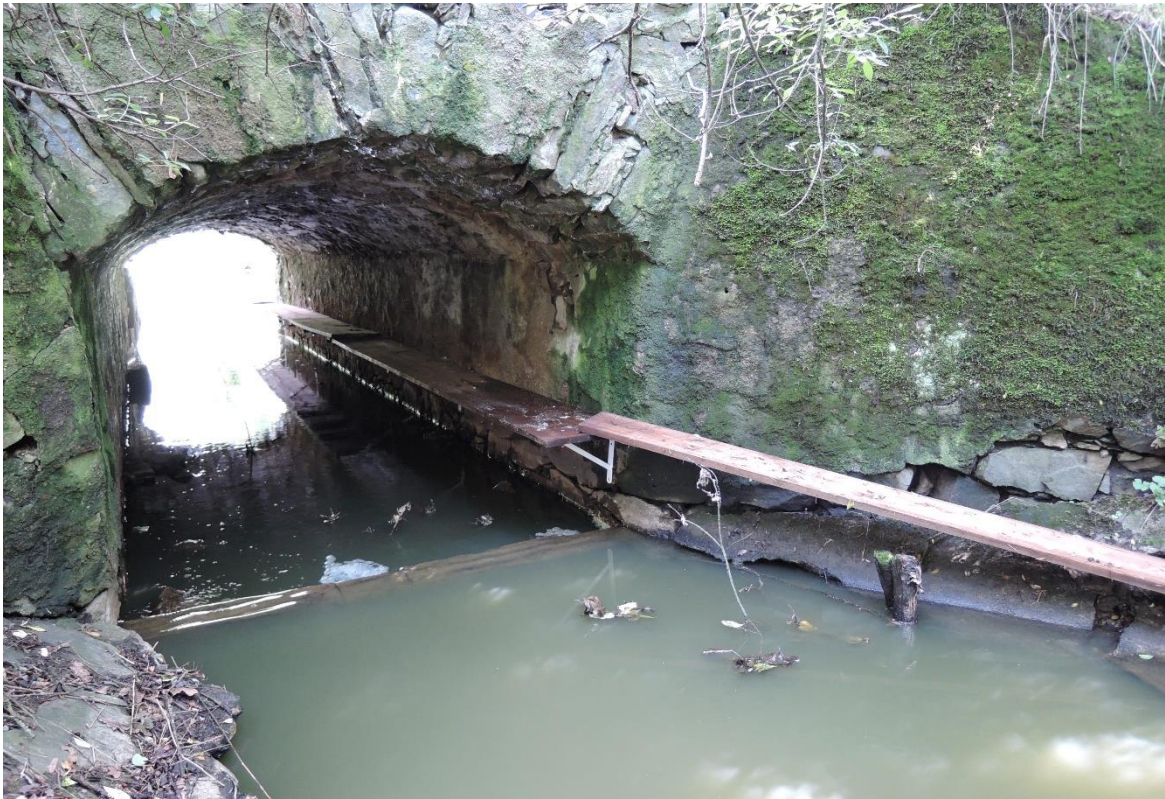
Obr. 9 Lávka instalována na výtoku z rybníka Perklas, silnice č. 24, Jihočeský kraj (ID Ponědraž 1) Fig. 9 Board installed on channel of Perklas pond, road no. 24, South Bohemia (ID Ponědraž 1)
