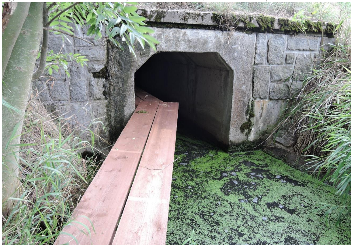
Obr. 8 Lávka instalována na výtoku z rybníka Velký Tisý, silnice č. 24, Jihočeský kraj (ID Lomnice nad Lužnicí 1)
