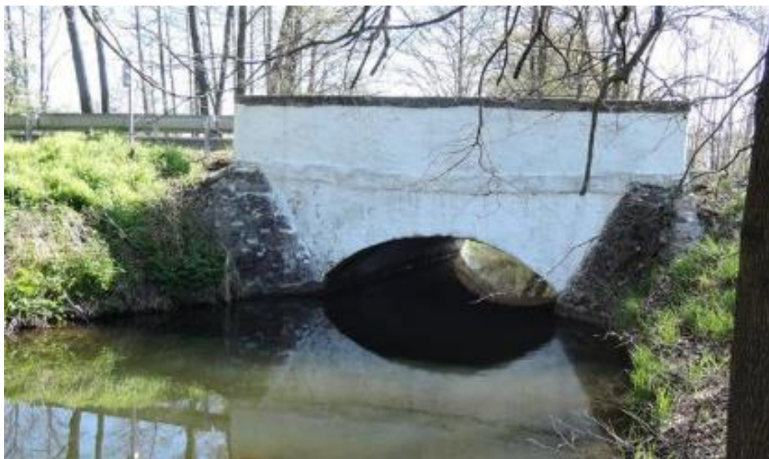
Obr. 1. Typický most, kde voda teče od opěry k opěře a kde by dřevěná lávka byla vhodným opatřením pro zlepšení průchodnosti (Zlatá Stoka, silnice č. 24).
