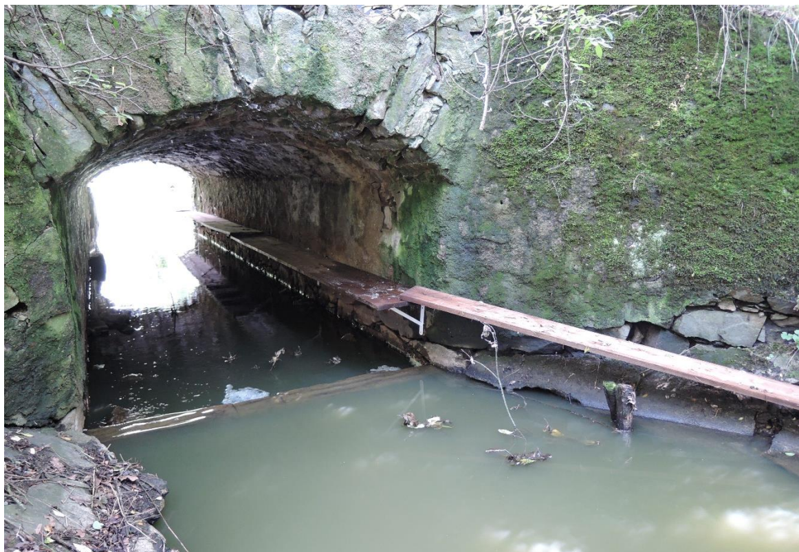
Obr. 9 Lávka instalována na výtoku z rybníka Perklas, silnice č. 24, Jihočeský kraj (ID Ponědraž 1) Fig. 9 Board installed on channel of Perklas pond, road no. 24, South Bohemia (ID Ponědraž 1)
