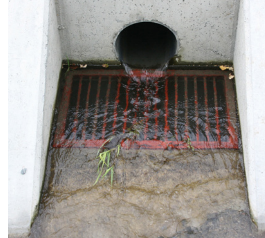
Usazovací nádrže u propustek znemožňují, aby zvířata používala propustky jako bezpečný podchod pod silnicí.
